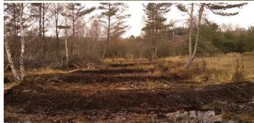
Travaux de restauration hydraulique à Lachaud. Pose de planches avec merlon de tourbe pour neutraliser un ancien drain
